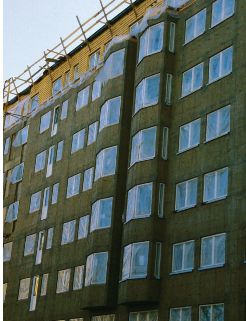
TINKUOJAMO FASADO ŠILTINIMO SISTEMA.
