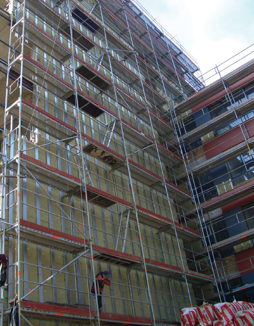
VĒDINAMOJO FASADO ŠILTINIMO SISTEMA.
