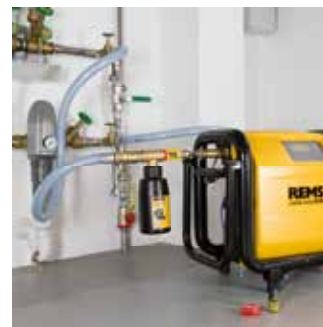
Geriamajį vandenį tiekiančių pastatų vidaus vandentiekio dezinfekcija
