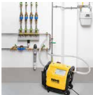
Geriamajį vandenį tiekiančių pastatų vidaus vandentiekio plovimas
