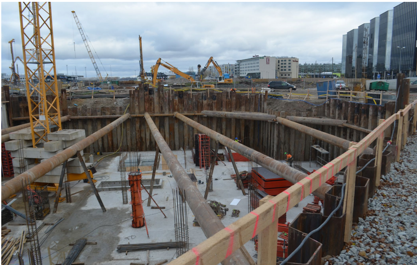
Požeminė pastato konstrukcija Talino uoste
