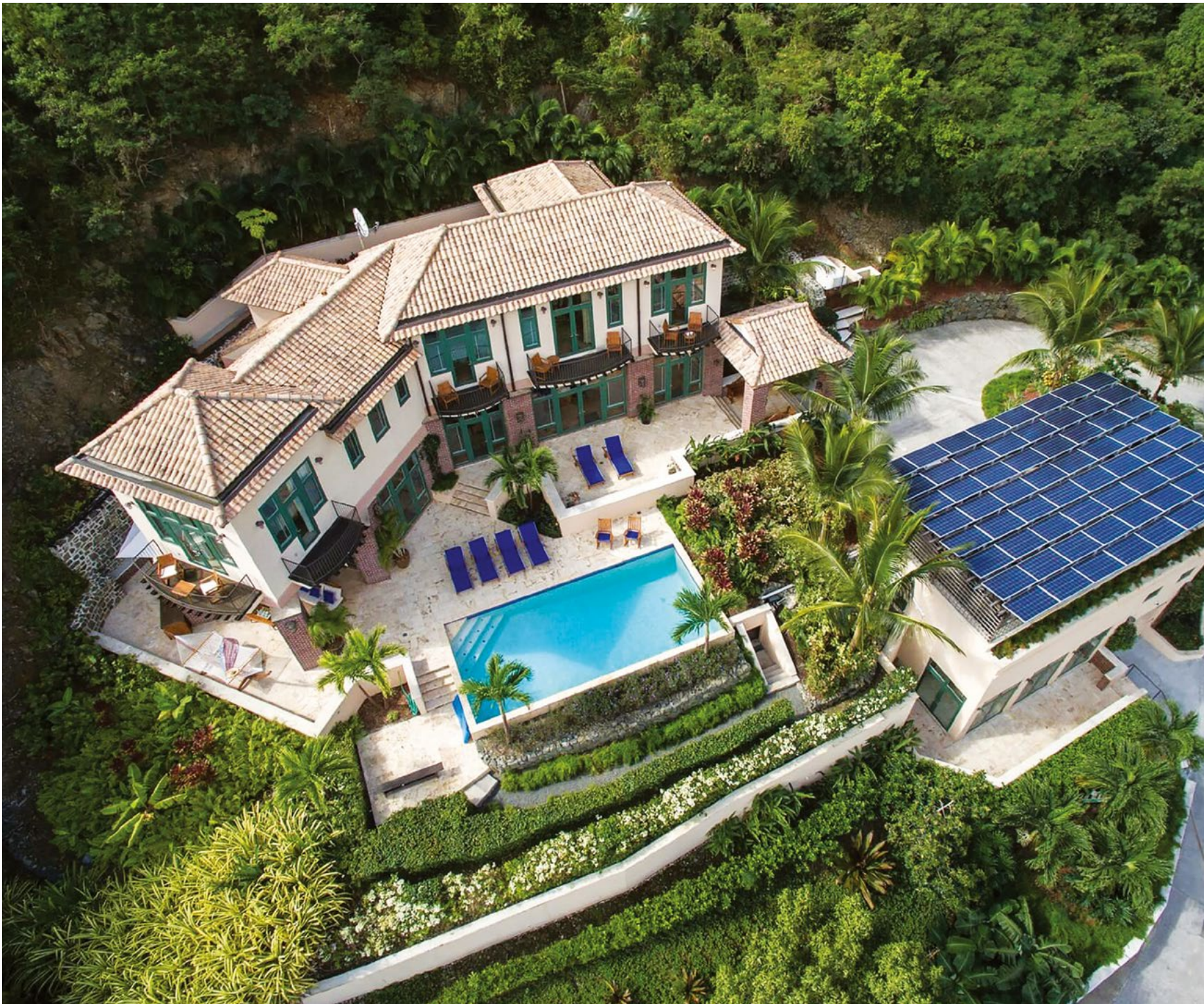
Namas Maho įlankoje yra oazė šiauriniame Sent Džono krante JAV Mergelių salose. Saulės baterijų stogas ir generatorius užtikrina nepriklausomą energijos tiekimą.
