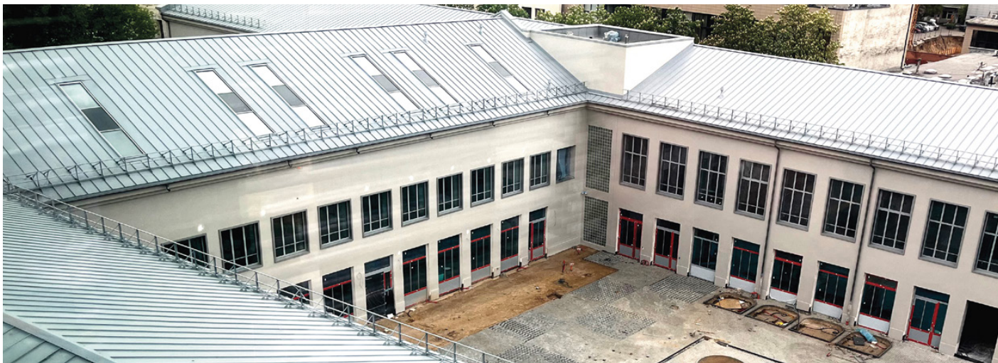
Dešinėje - visiškai restauruotas fasadas, kairėje - užtaisytas ir pertinkuotas fasadas dar be dažų sluoksnio
