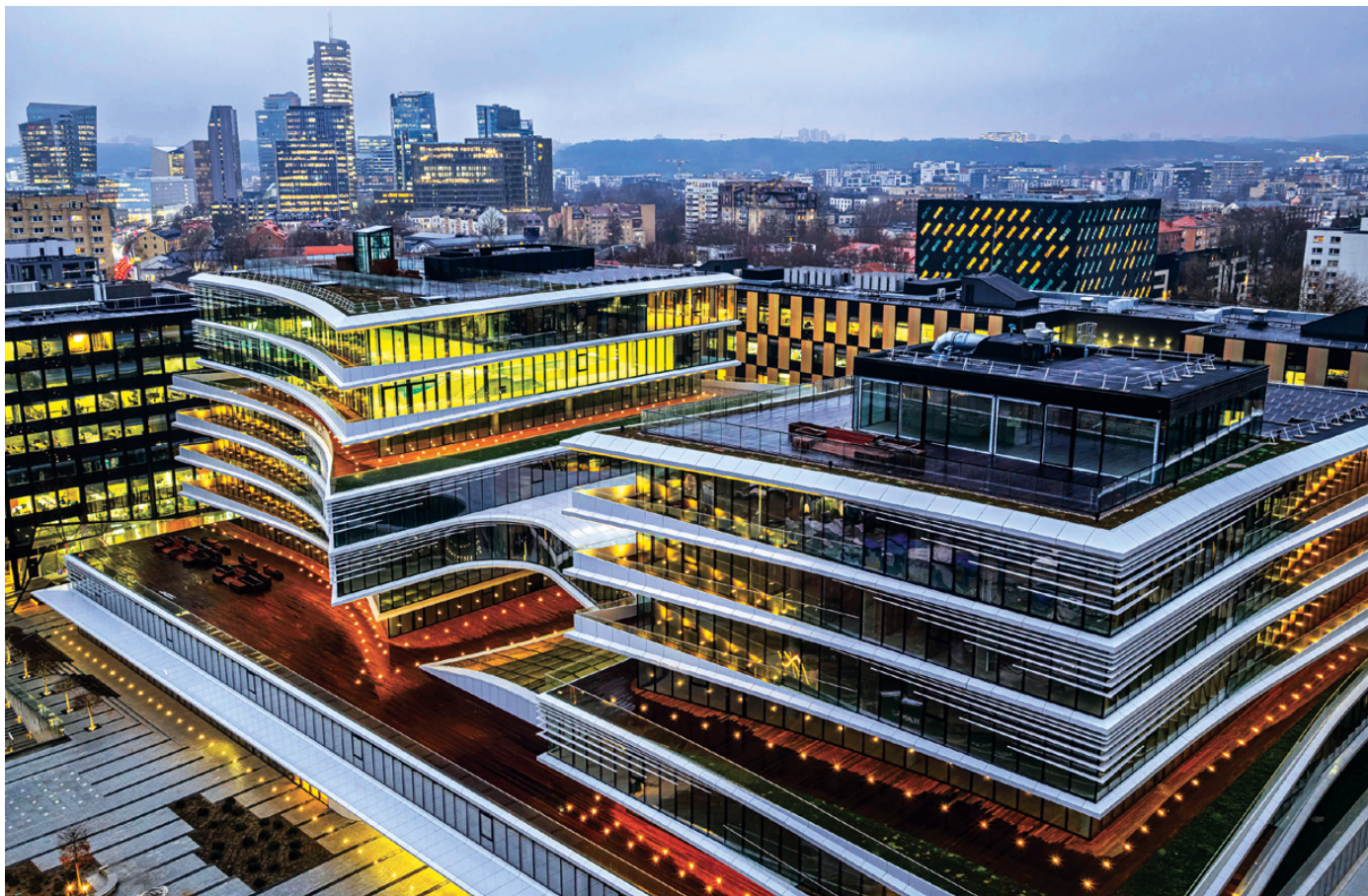
UAB „Delta Nova“ atliko „Business Stadium Central“ pastato Rinktinės g. 3 Vilniuje perdangų įtempto armavimo darbus
